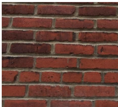
Réfection des joints au ciment
