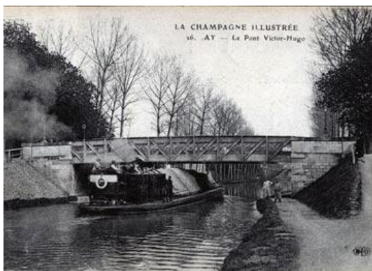
Ouvrage disparu, Pont Victor Hugo, Aÿ
