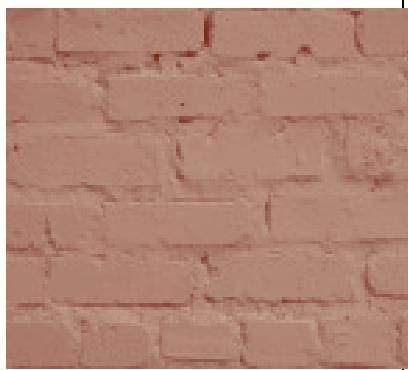
Mise en peinture de la brique
