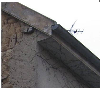
Enduit ciment rapporté sur la maçonnerie de brique crue
