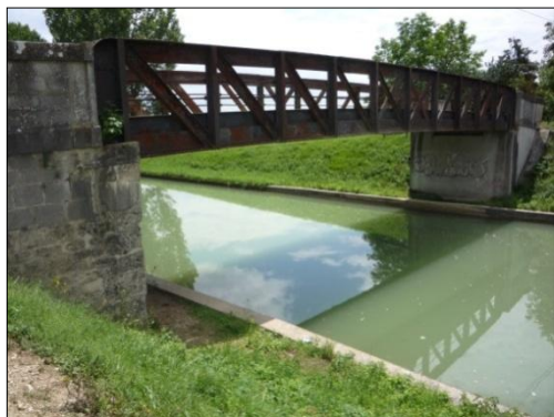
Ouvrage métallique au pont Malot, Hautvillers
