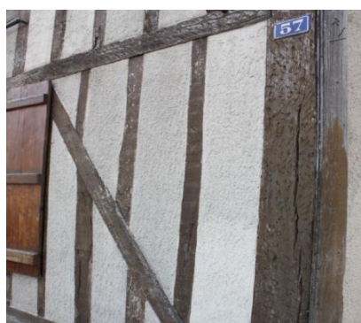
La finition du remplissage réalisée au rouleau. Une finition lissée est à privilégier ainsi qu'un badigeon homogénéisant l'ensemble.
