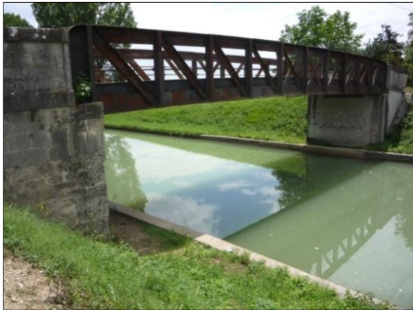
Pont Malot en l'état actuel
