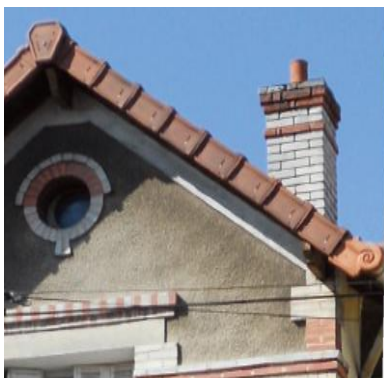
Suppression ou simplification des accessoires (tuiles de rive)
