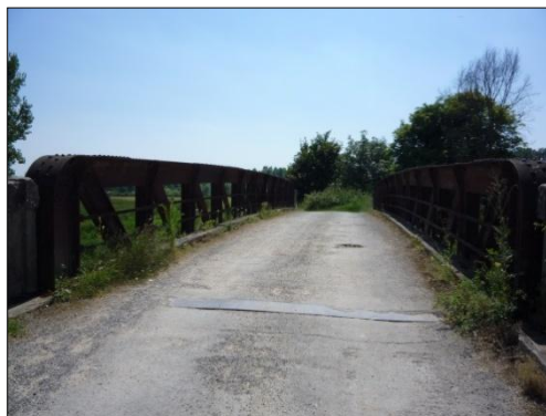
Ouvrage métallique du Cheminet, Mareuil sur Aÿ
