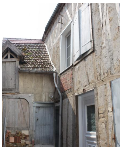
Bâtiments sur cour à pan de bois
