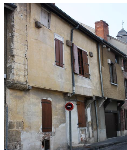
Maisons de ville La façade est enduite mais les abouts de poutre et l'encorbellement laissent supposer une structure à pan de bois
