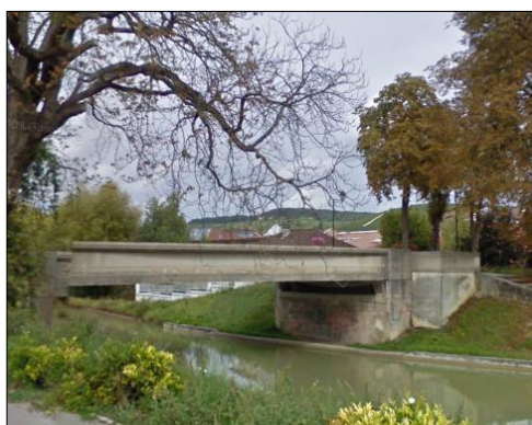
Ouvrage béton, Pont Victor Hugo, Aÿ
