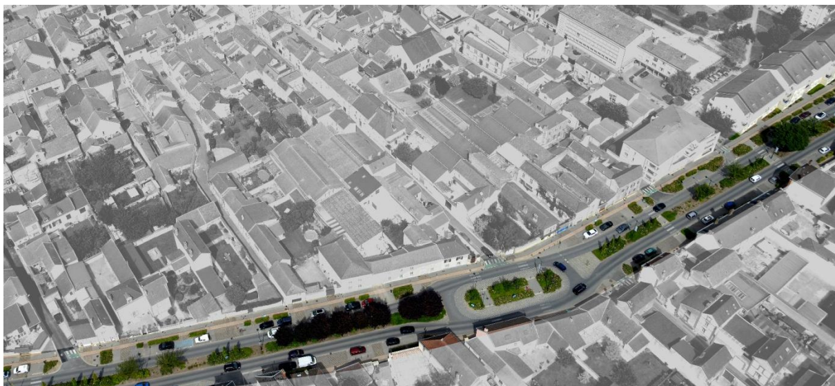
Traitement d'un boulevard à Aÿ
