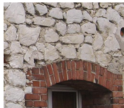
Piochage de l'enduit, mise à nu de la maçonnerie non destinée à être vue
