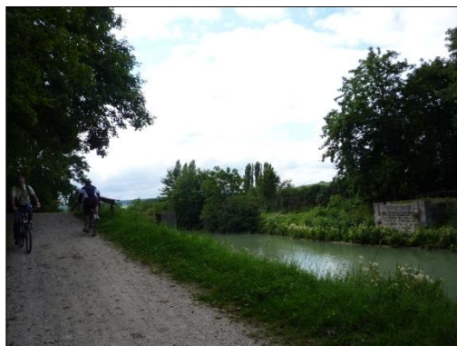
Culées anciennes à Aÿ
