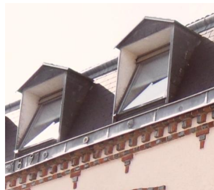
Disposition non traditionnelle de lucarne associant des châssis de toit
