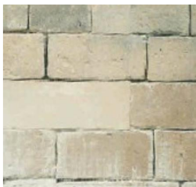
Dégarnissage des joints avec épaufrage des arêtes des pierres
