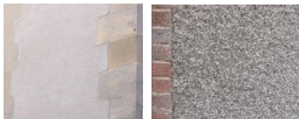
Différents types de finition de l'enduit : lissée, projeté
