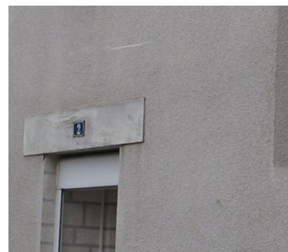
Substitution de l'enduit traditionnel à base de plâtre et de chaux par un enduit ciment
