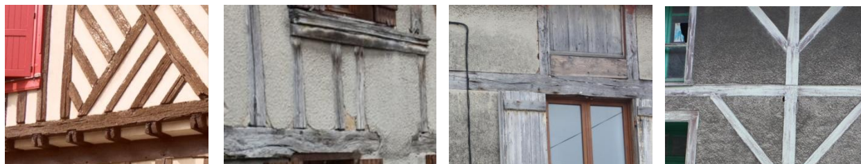
Différents traitements du pan de bois correspondant à des époques différentes
