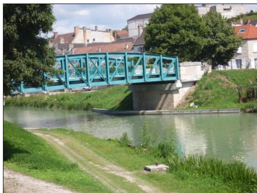
Ouvrage métallique de la D112, Mareuil sur Aÿ
