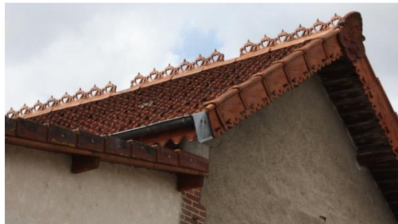
Les différents types de toiture en tuile plate en terre cuite petit moule ou en tuile à emboîtement
