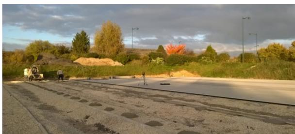
Réalisation de la plate-forme, pose des plots de niveau et drains, et coulage du béton.
